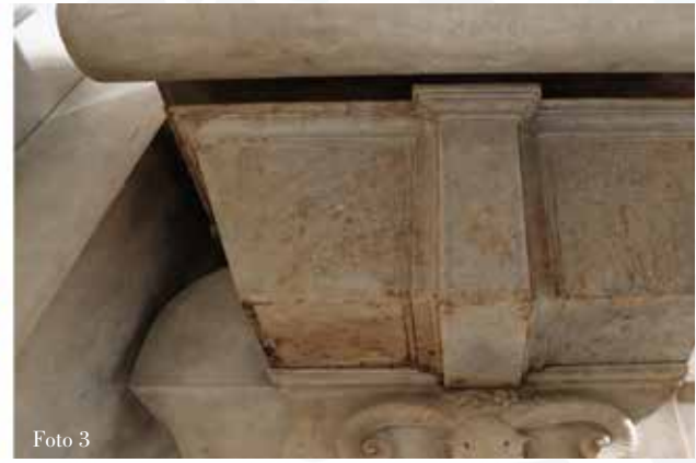
Biopulitura, sarcofago di Lorenzo Duca d'Urbino: a sinistra, i depositi da rimuovere e a destra, il marmo dopo la biopulitura
