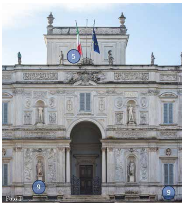
Facciata sud del Casino Algardi (Roma), analizzata per la biodiversità associata ai punti di prelievo dei biofilm.
